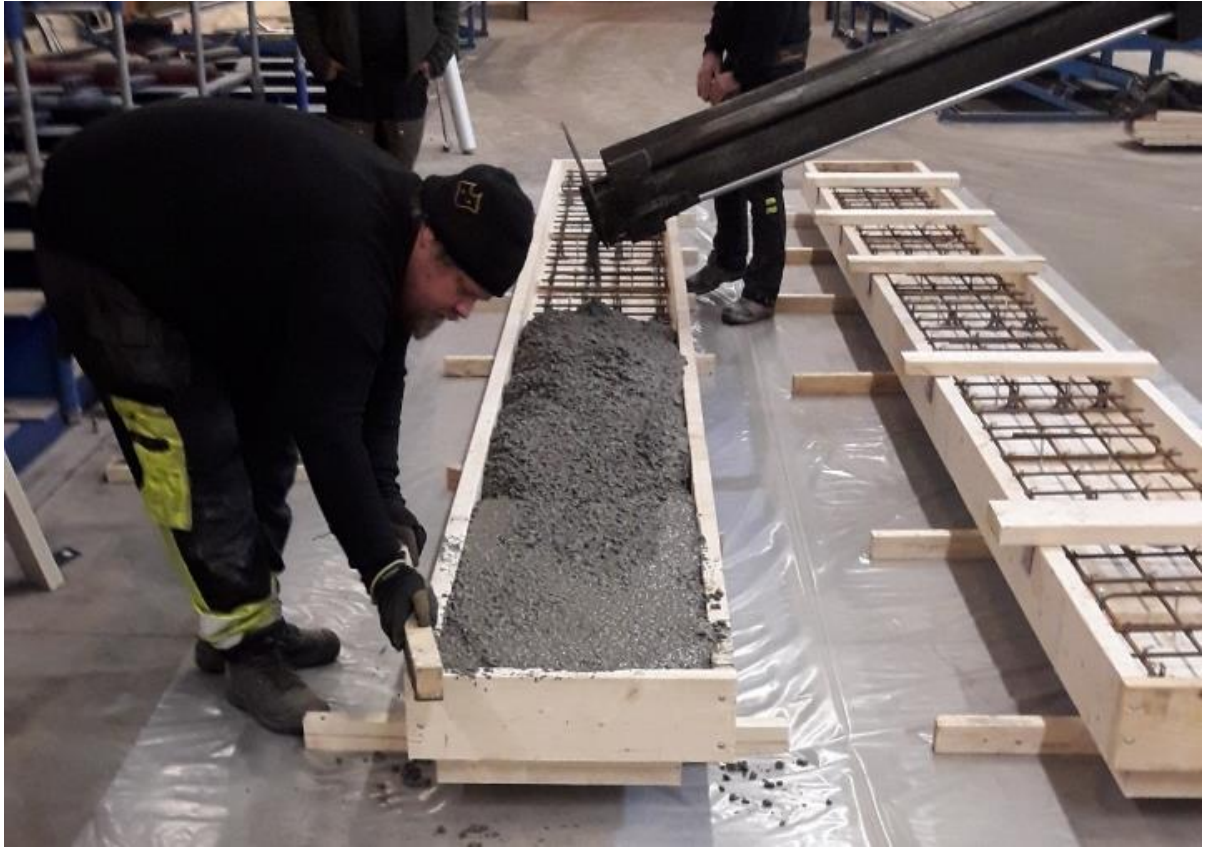
Figur 2. Gjutning från betongbil i provisorisk station.
