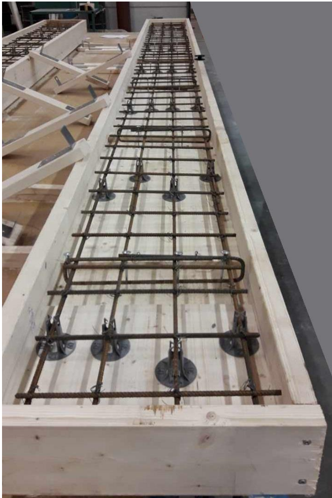
Figur 1. Formning och armering.
