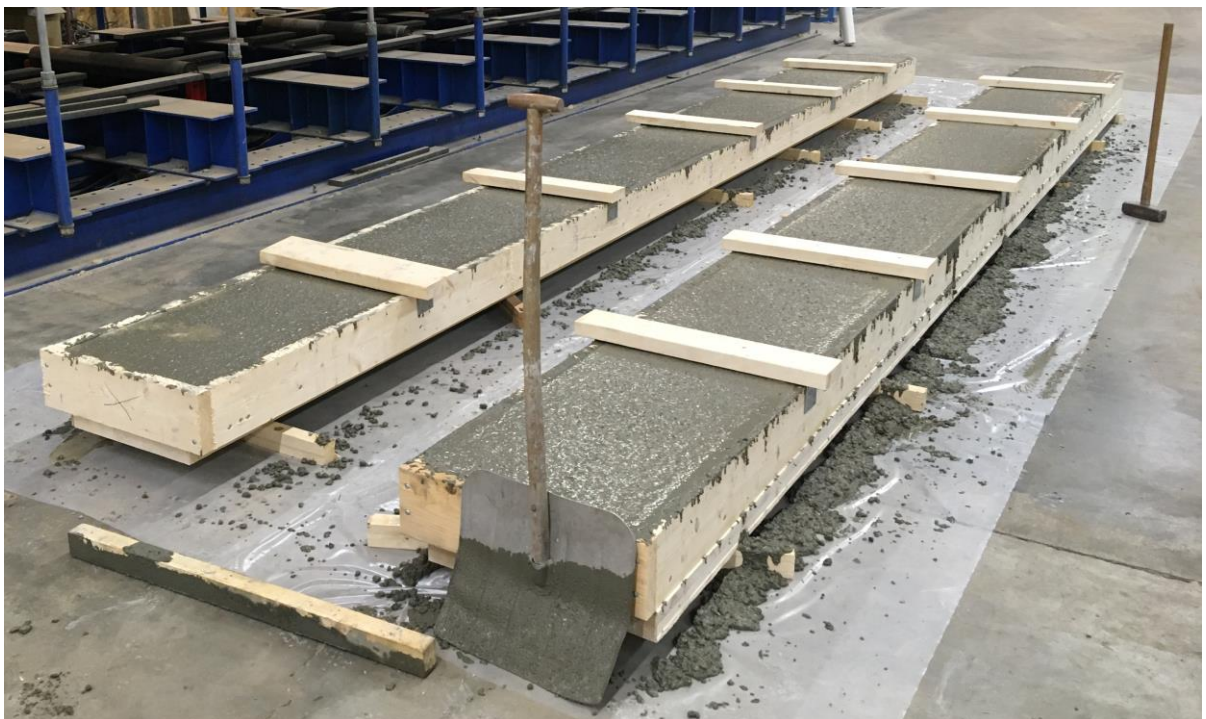
Figur 2. Gjutning från betongbil i provisorisk station.
