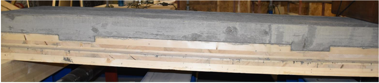
Figur 6. Bjälklaget vid 126 kN last, dvs endast 200 kg till krävdes för att bryta bjälklaget. Notera de tydliga 45°-sprickorna på upplagssidorna av urtagen. Den högra ledde sedan till brott. Notera även hur betongskivan försöker lyfta sig ur trä.
